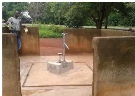
Pompe hydro-pompe (Vergnet)
